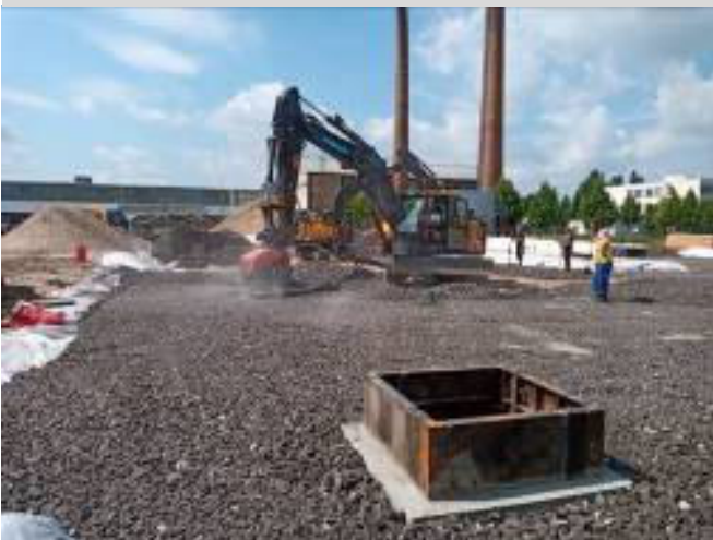
Kontrolle und Nachweis mit der dynamischen Lastplatte
