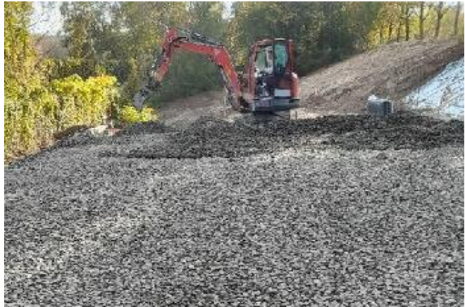
Einbau des Mittelteils – eine perfekte Einbautechnologie (Terrassenaufbau)
