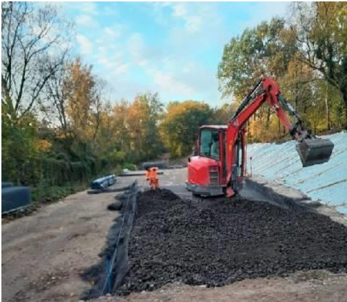
Einbau der ersten und zweiten Lage
