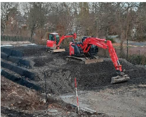
Einbau des Mittelteils – eine perfekte Einbautechnologie (Terrassenaufbau)
