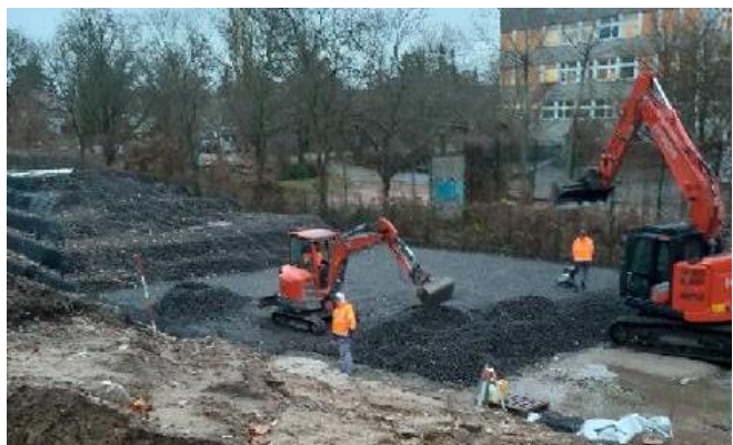
Einbau des Mittelteils – eine perfekte Einbautechnologie (Terrassenaufbau)
