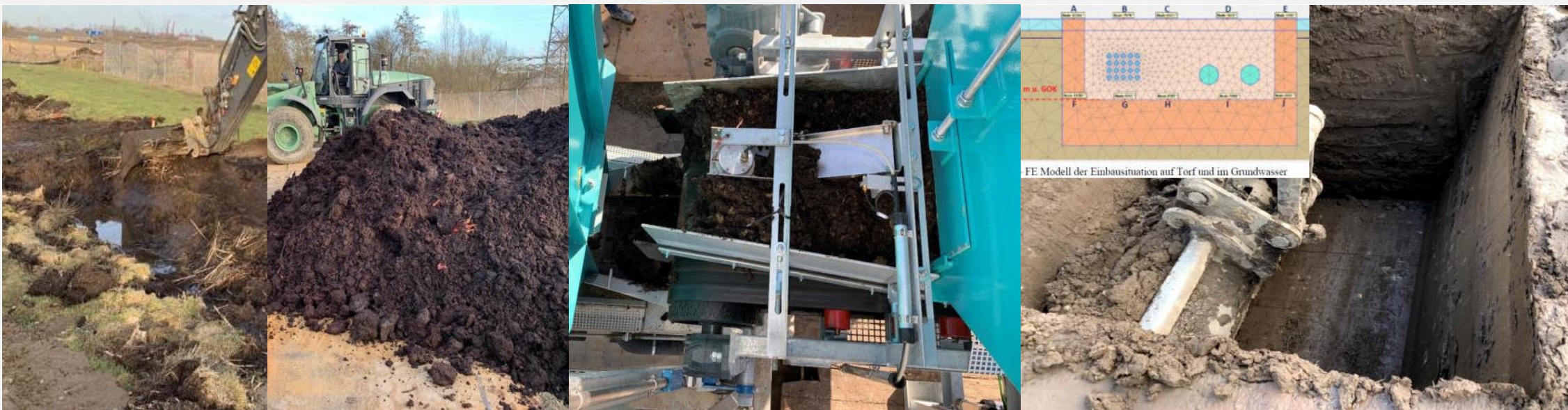
Bild 1-3 – Aushub von Torf für den Bau einer Gasleitungs- und Kabeltrasse im GW und Herstellung von FB
