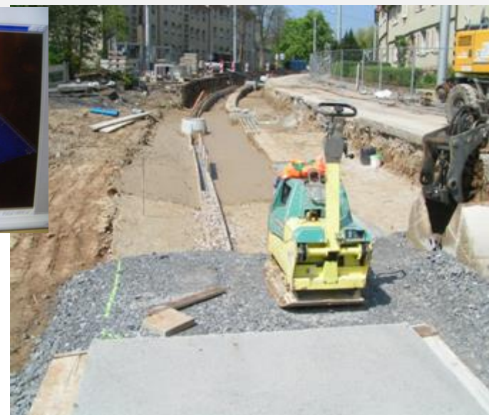
Bild 2 – Aufbau über der Bodenplatte aus RSS® Flüssigboden
