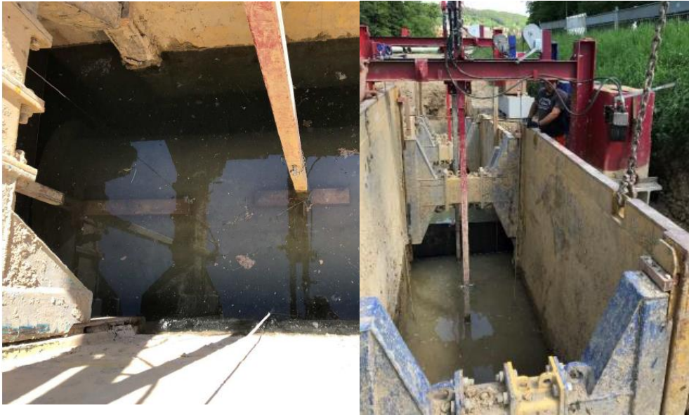
Bild 1 – „nasses“ Bauen unter dem Grundwasserspiegel
