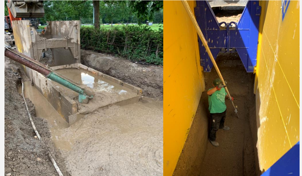
Bild 2 – „trockenes“ Bauen unter dem Grundwasserspiegel/Kehl
