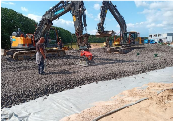
Gründungen und Bodenplatte für modulare Gebäude mit der Firma Kleusberg
