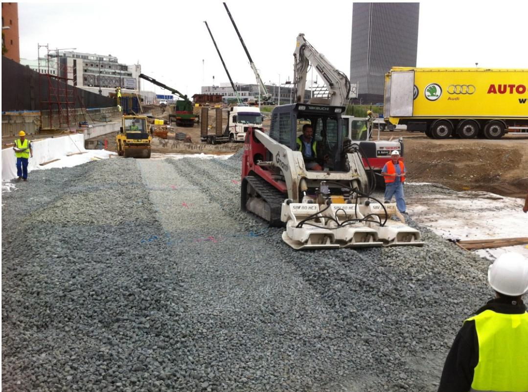
Abb. 7 Bobcat mit Plattenverdichter
