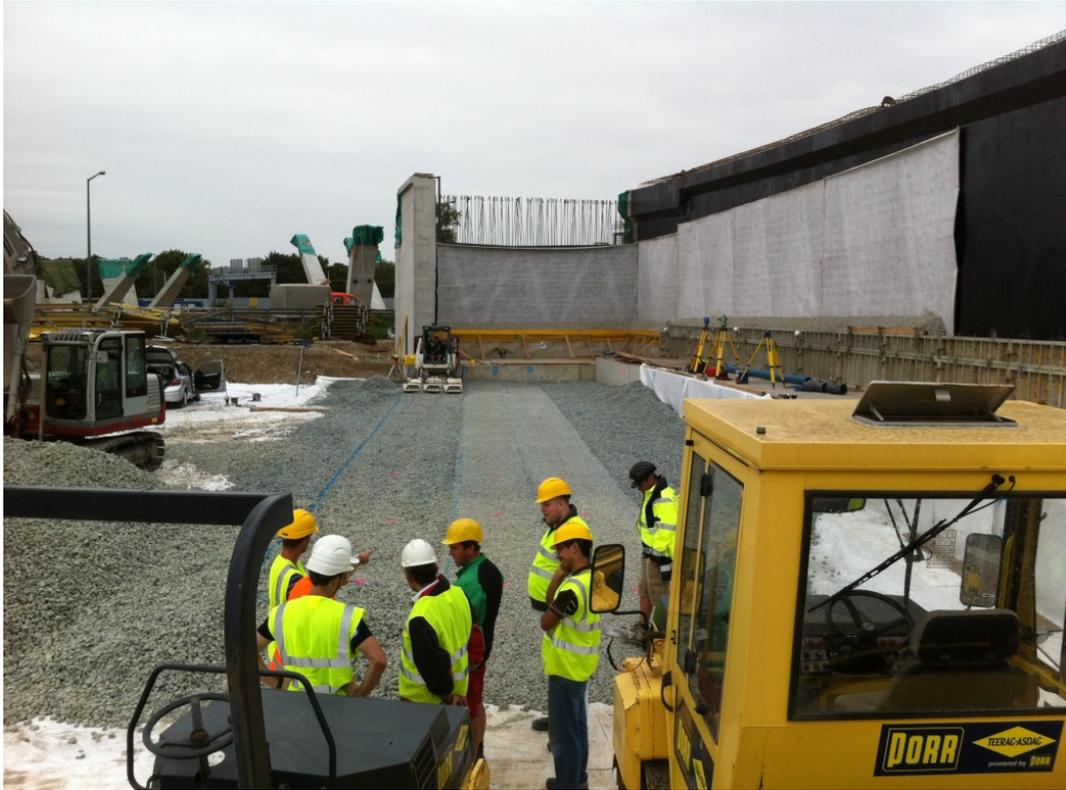
Abb. 6 Probefeld mit Bahnen für die Untersuchung der Wirkung der Verdichtungsgeräte.
