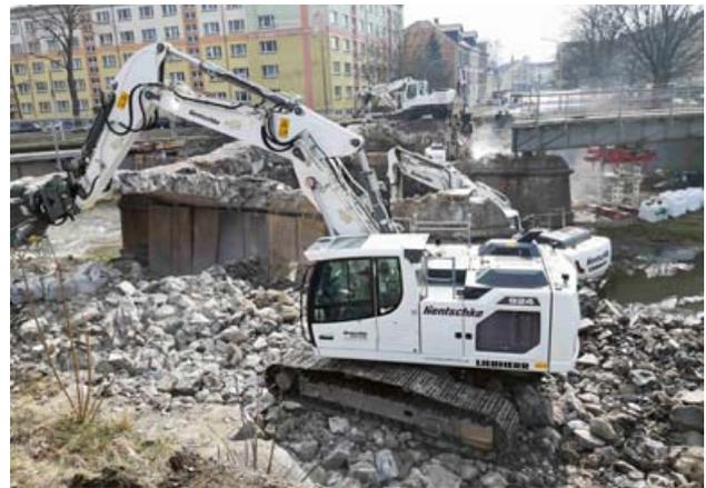
Bild 6: Streifenweiser Abbruch der drei Bögen
