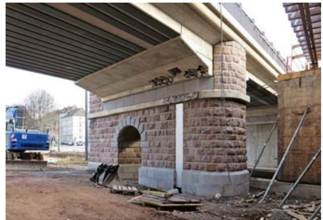
Bild 7: EÜ Augustusburger Straße – Walzträger in Beton, Stützen mit Natursteinverblendung
