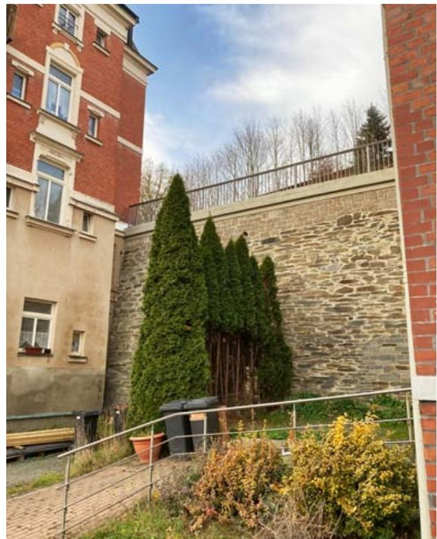
Bild 6: Sanierte und erhöhte Stützwand aus Blickrichtung „Letzter Heller“
