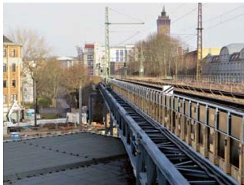
Bild 2: Chemnitzer Viadukt – Behelfs-Tragkonstruktion, welche die Oberleitungsmasten, Kabel und den Wartungsweg trägt
