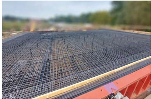
Bild 8: Carbonbewehrung S 111 Wurschen vor der Betonage
