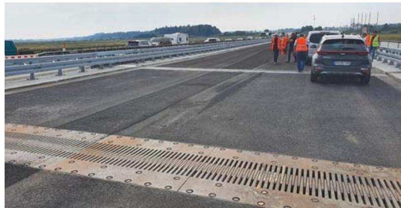
Bild 7: Fast fertiggestellte Brücke RF Lübeck, daneben Behelfsbrücke unter Verkehr. Das Bild zeigt einen ca. 10 m langen Zwischenabschnitt zwischen der Treibelbrücke und dem Neubau der Dammbücke mit den beiden Fahrbahnübergangskonstruktionen.
