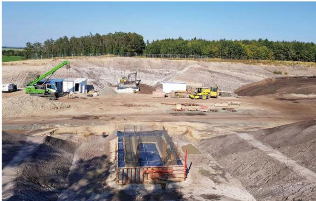
Bild 2: Baufeld BW 63Ü. Gut erkennbar, die regellose Baugrundsituation. Die Schüttfolgen der Absetzerkippe sind an den streifenförmigen Mustern gut zu erkennen, leider erst, wenn sie so schön freigelegt sind wie im Bild.
