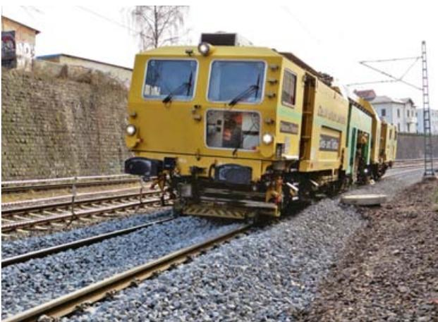
Bild 6: Gleisstopfvorgang – für Straßenbauingenieure nicht tägliches Erleben und damit mal über den Tellerrand geschaut
