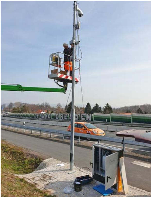
Bild 2: Aufbau von IVS-Komponenten (Kamera, Bluetooth-Reisezeitsensor, Roadside Unit)
