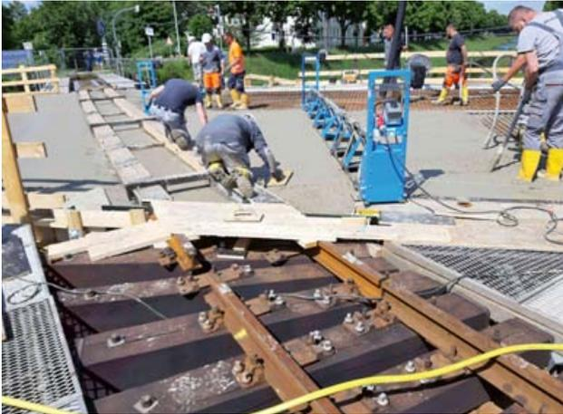
Bild 8: Betonage der Fahrbahnplatte am Schienentrog
