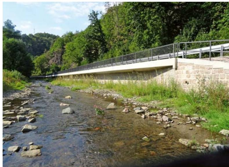
Bild 6: Ersatzneubau Stützwand 19
