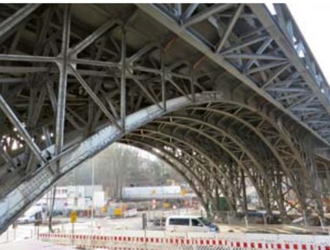
Bild 1: Chemnitzer Viadukt – Unterseite auf die vier Hauptbögen mit Behelfs-Tragkonstruktion parallel
