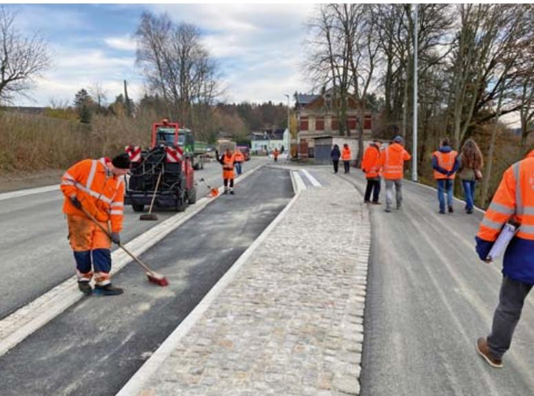
Bild 4: Letzte Restarbeiten im Bereich der barrierefrei ausgebauten Bushaltestellen
