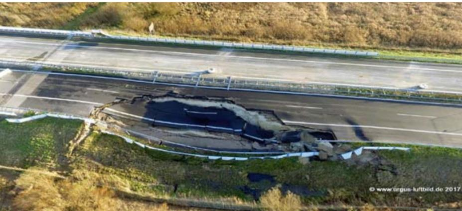
Bild 4: Grundbruch Richtungsfahrbahn Lübeck
