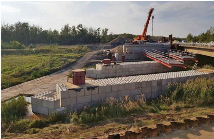
Bild 4: Baufeld BW 67, vorn bauzeitliche Hilfsstützen
