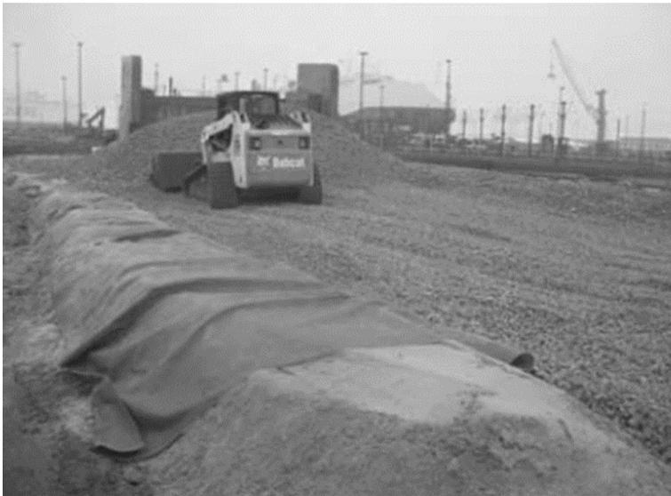
Bild 5: Schaumglasschüttung für die Rampe einer Autobrücke im Port Bremerhaven
