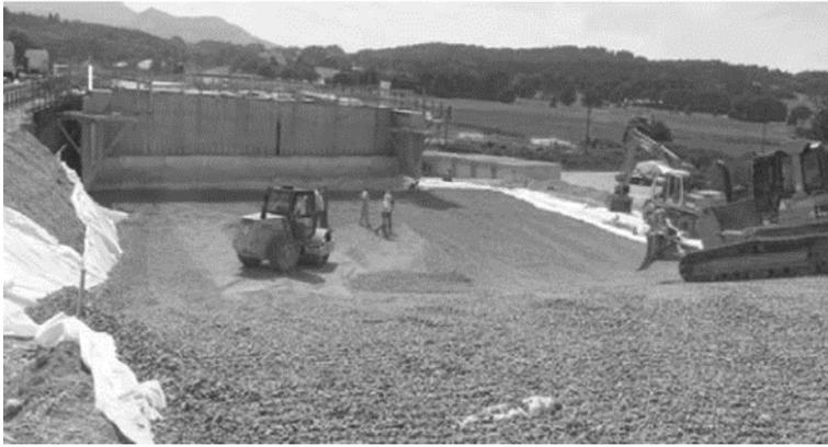
Bild 4: Beispiel für die Rampe einer Autobahnbrücke an der A 8 bei Bernau am Chiemsee unter Verwendung einer Schaumglasschüttung
