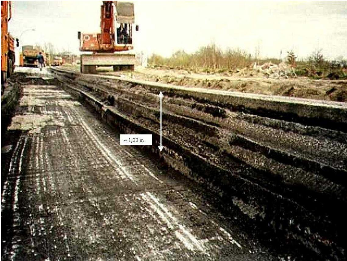
Bild 8: Dicke Asphalt-schichten nach mehrfacher Wiederherstellung der Gradientenhöhe zum Ausgleich von Setzungen (vor der Sanierung)
