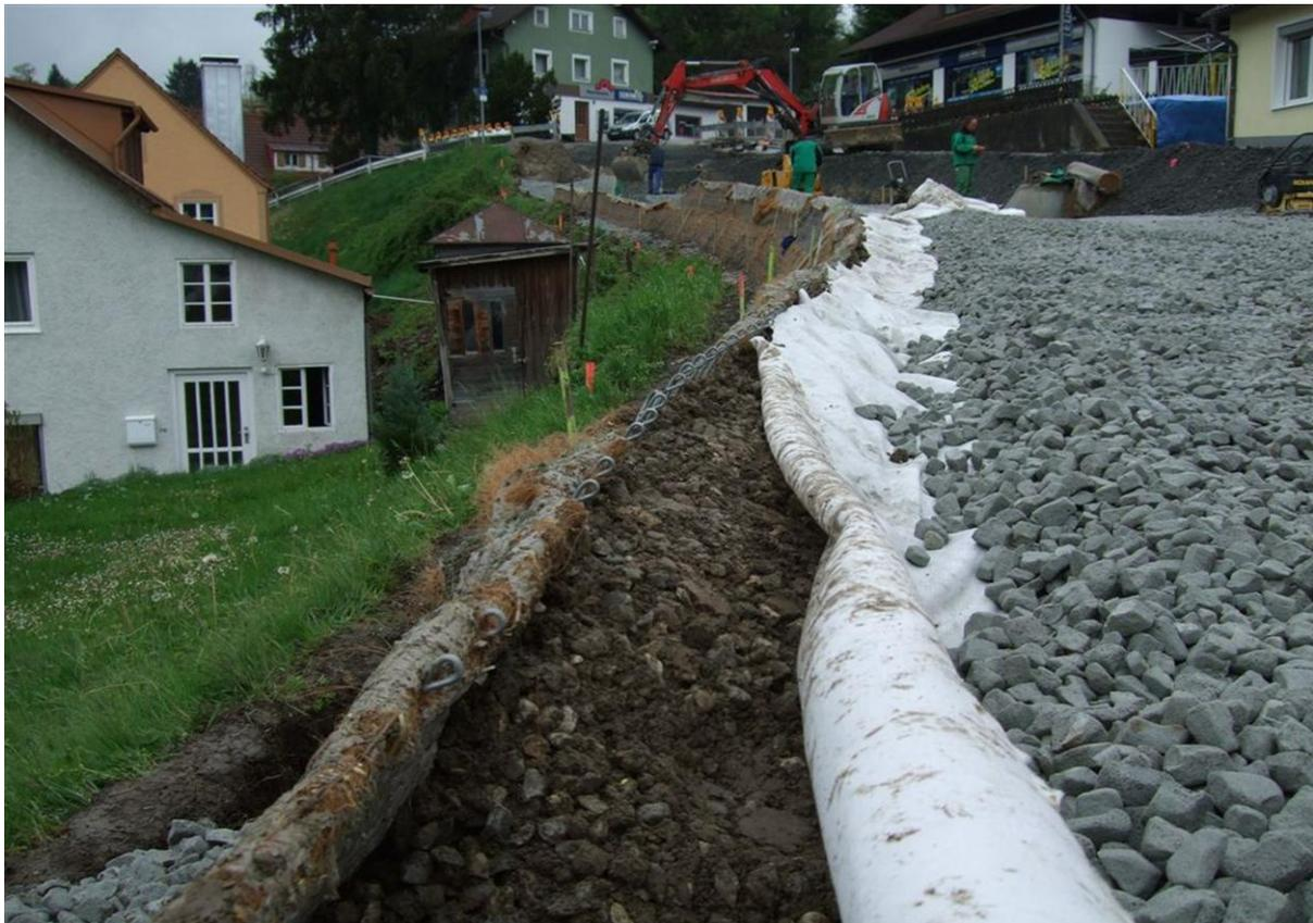
Bild 7: Beispiel der Verbreiterung eines Straßendamms mit Stützkörper (links im Bild) und Schaumglasschüttung (rechts im Bild) in Kempten
