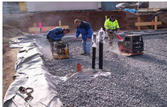
Feuerwehrgebäude in Frankfurt im Passivhausstandart auf 60 cm SGS Gründungspolster, optimiert
