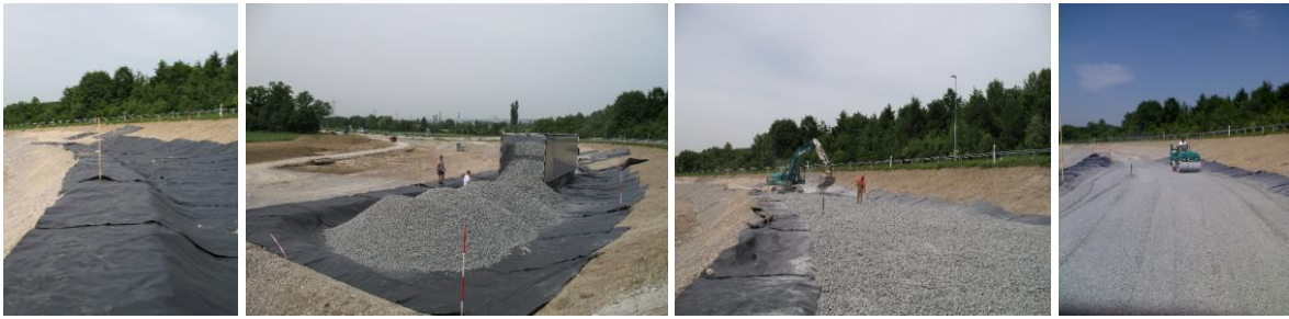
Stützwälle bei der Herstellung einer Schaumglasschüttung
