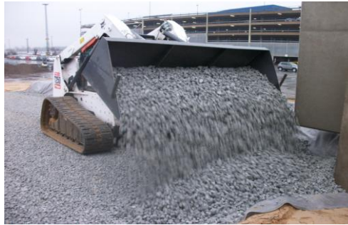
Verteilung mit Kompaktlader 2,5 m 3 Schaufel
