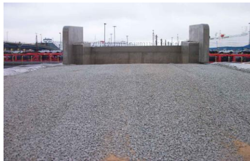
Verdichtung mit Kompaktlader und 2,5 m breiter Anbauverdichterplatte, Fertigstellung in 2 Tagen
