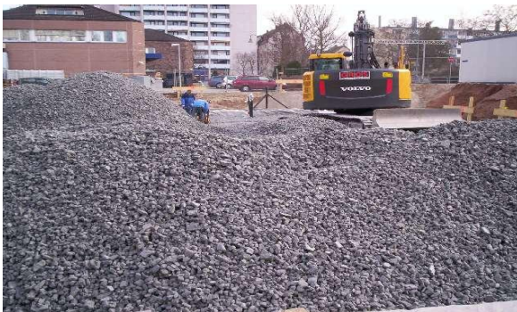
Feuerwehrgebäude in Frankfurt im Passivhausstandart auf 60 cm SGS Gründungspolster, optimiert
