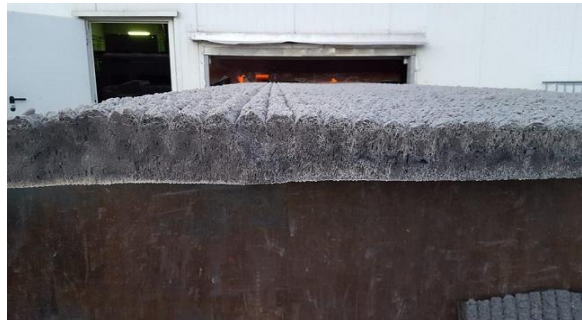
Schaumglasschotterplatte am Tunnelende
