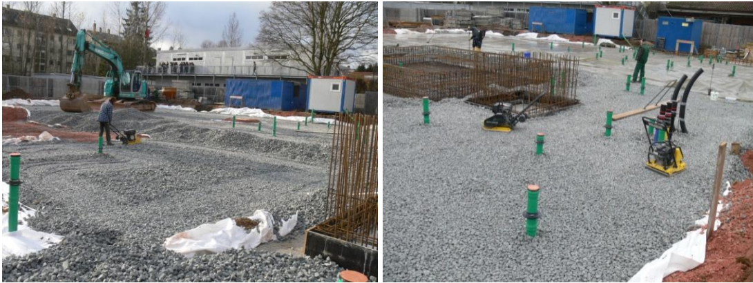
Schulgebäude in Frankfurt im Passivhausstandart auf 40 cm SGS Gründungspolster, optimiert, fachgerecht eingebaut
